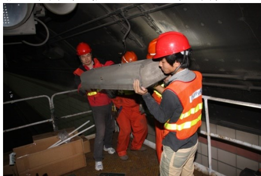
图5 庞大且笨重的原荧光灯灯具
