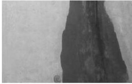
图 5 渗漏水原始图像
