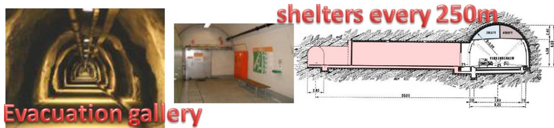
图 2.1 瑞士 St.Gotthard 隧道逃生救援平行导洞与避难所 [6]
