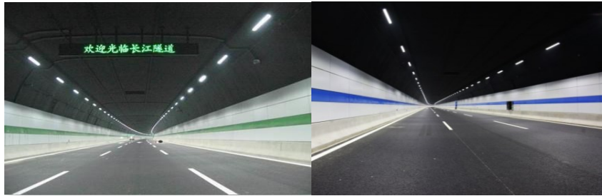
图 1 上海长江隧道照明
