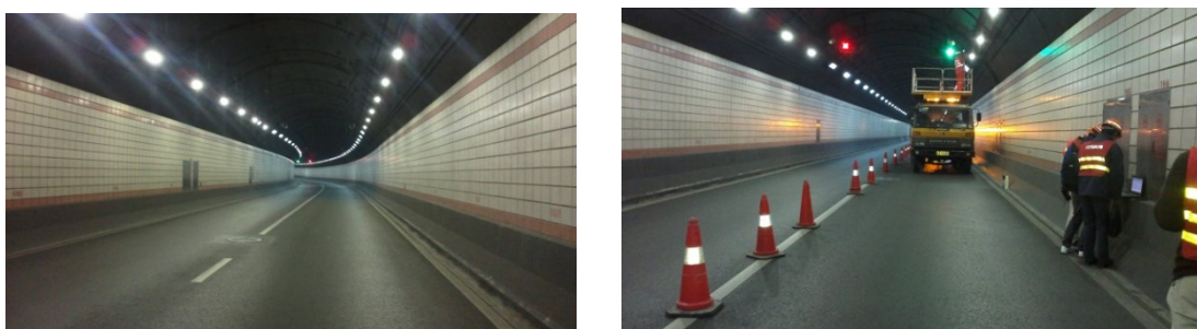
图 7 大连路隧道 LED 照明改造后效果图
