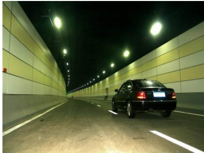
图 2 上海人民路隧道北线照明
