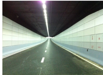
图 3 上海迎宾三路隧道照明
