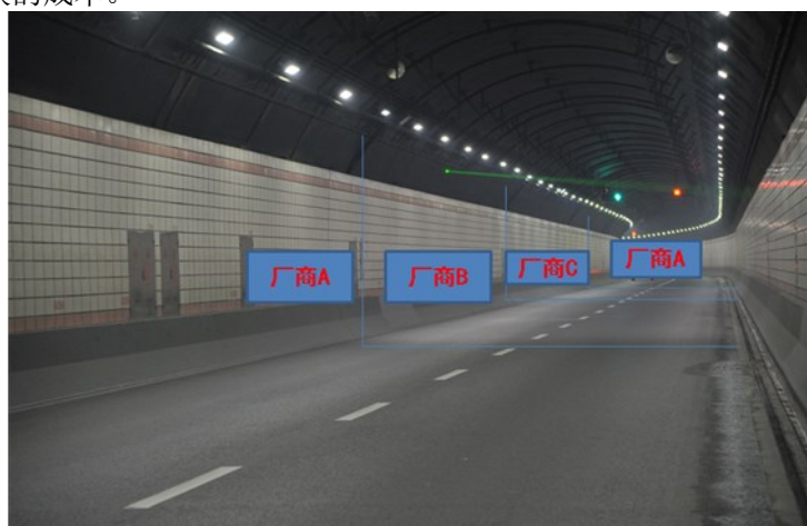
图 9 三个厂家的灯具混装，光度接口标准化、安装支架标准化、驱动电源与控制协议的标准化
